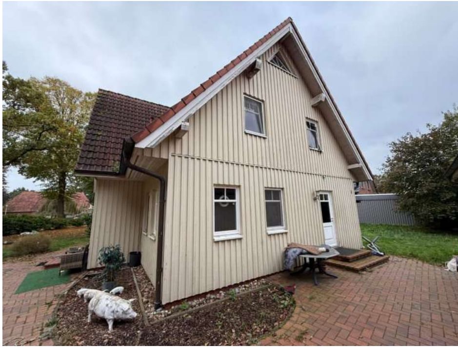
Nr. 5 Zustand Fassade
