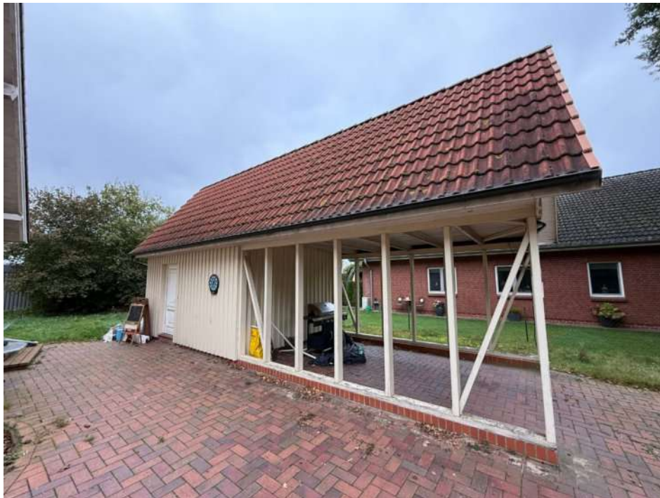
Nr. 6 Carport mit Gerätekammer
