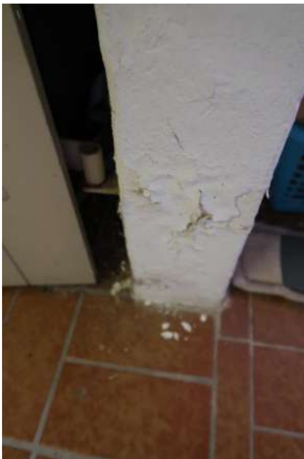
- Kellergeschoss Feuchtigkeitsschaden an der Wand sichtbar -
