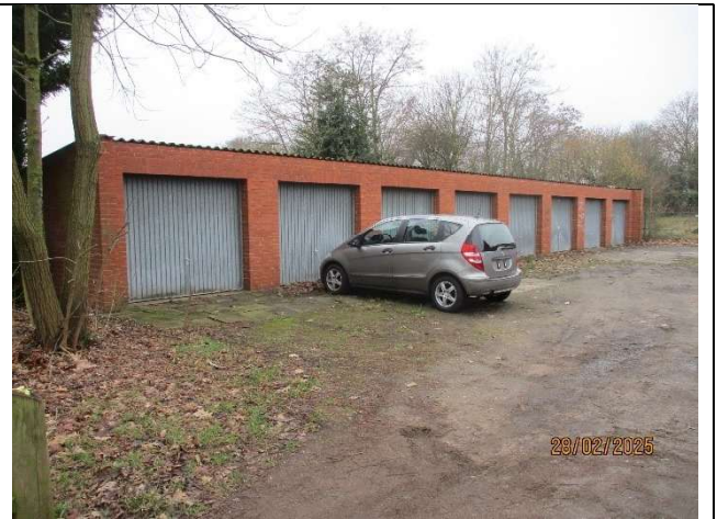
Ansicht von der Martinsheidestraße (südlich)
