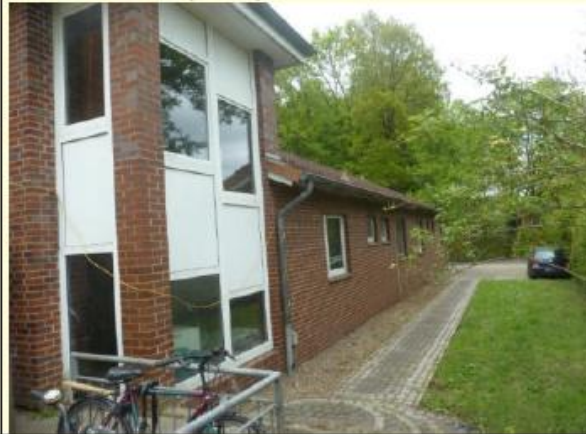
Seitliche Ansicht (Osten)
