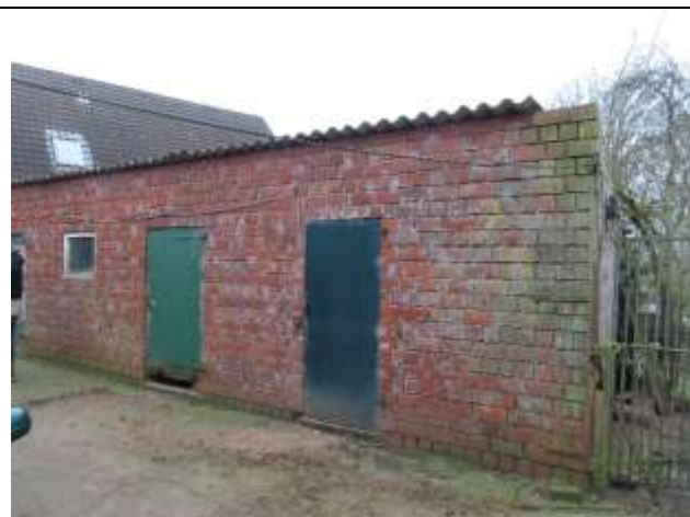
nicht genehmigtes massives Gebäude
