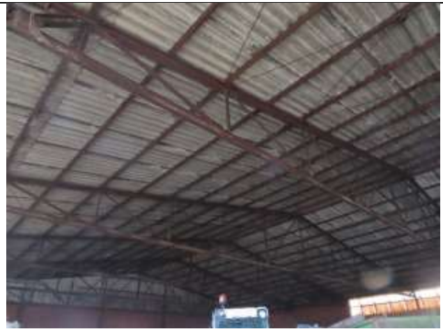
Ansicht Dach der Maschinenalle
