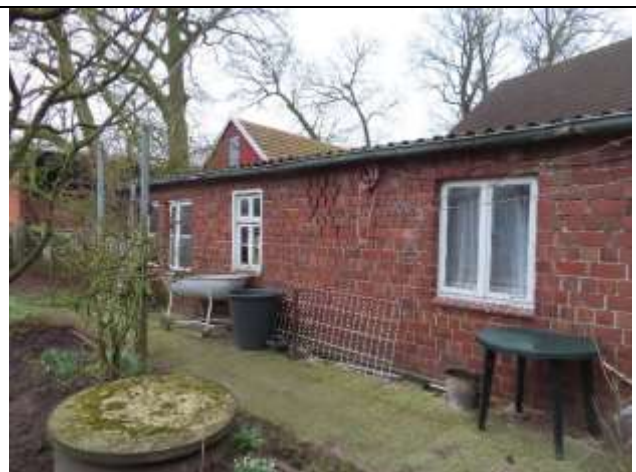
nicht genehmigtes massives Gebäude
