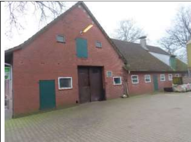
Ansicht von der Hofeinfahrt
