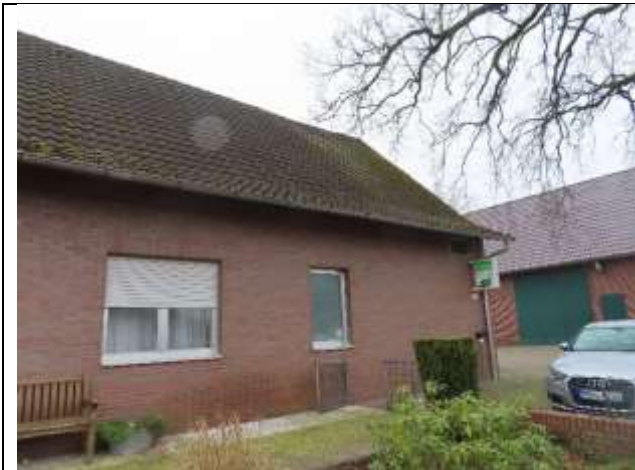
Wohnhaus mit Übergang Wirtschaftsgebäude
