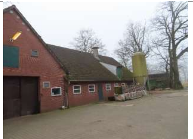
Ansicht von der Hofeinfahrt
