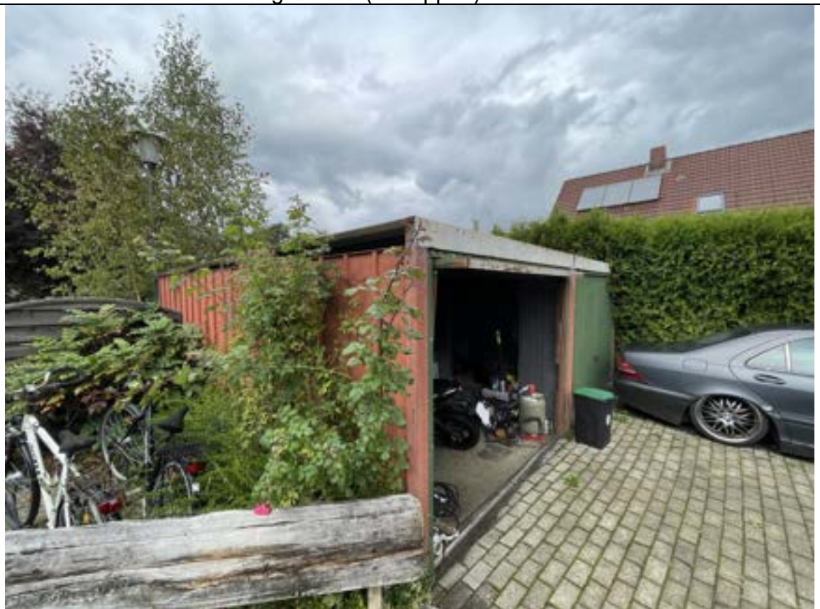
Nebengebäude (Doppelgarage) Außenansicht
