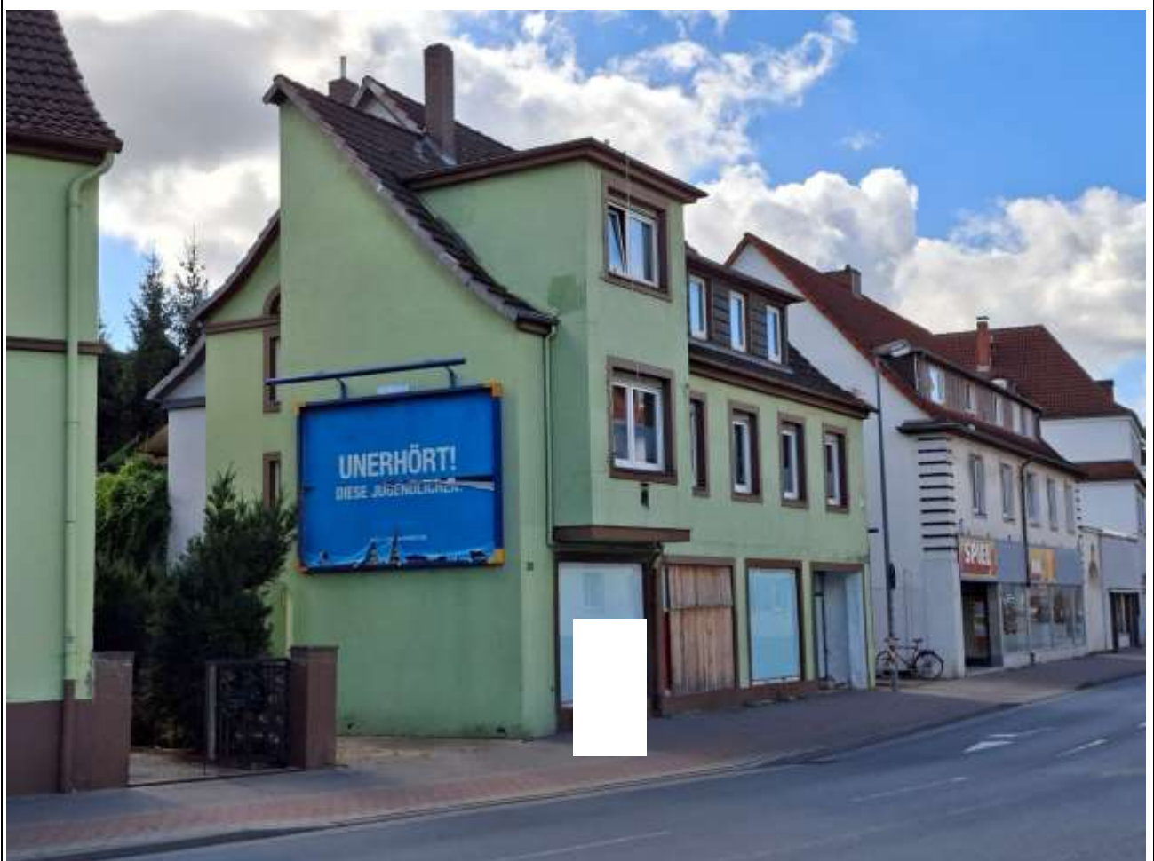
Ansicht der Nord-West-Fassade (Trauf- und Straßenseite) und Ansicht der Nord-Ost-Fassade (Giebel- und Hofseite)
