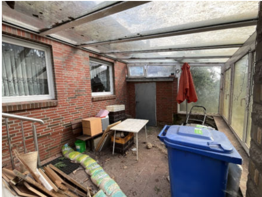
Überdachung mit Zugang zum Garagengebäude
