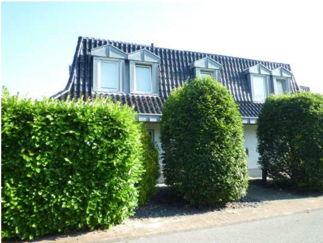
Frontansicht links / Ansicht aus südlicher Richtung
